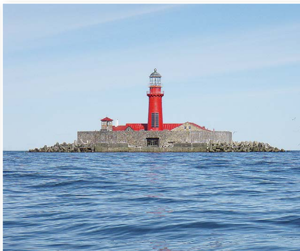
Leuchtturm von Kolka
